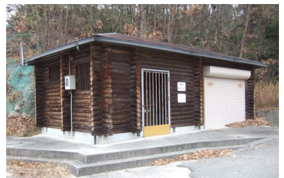
荒代海岸トイレ・倉庫
