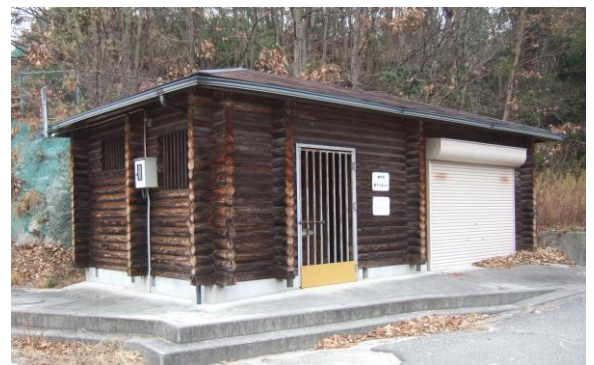
荒代海岸トイレ・倉庫
