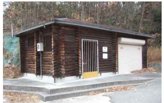
荒代海岸トイレ・倉庫
