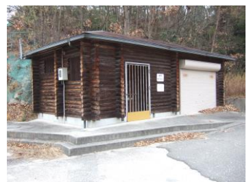
荒代海岸トイレ・倉庫
