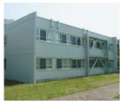
宿泊棟耐震工事
