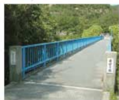
希望の橋塗装工事
