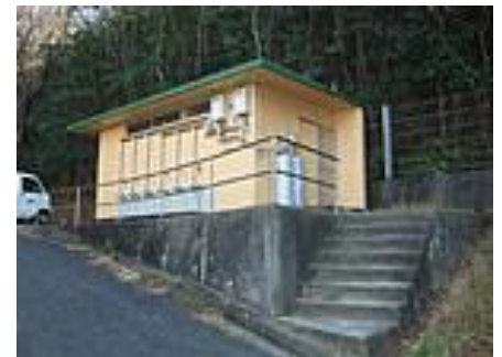
トイレ・シャワー場
